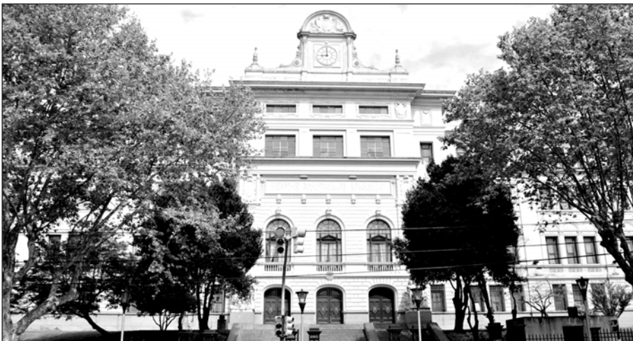
Instituto Félix Bernasconi, Ciudad de Buenos Aires (construido en 1921)
